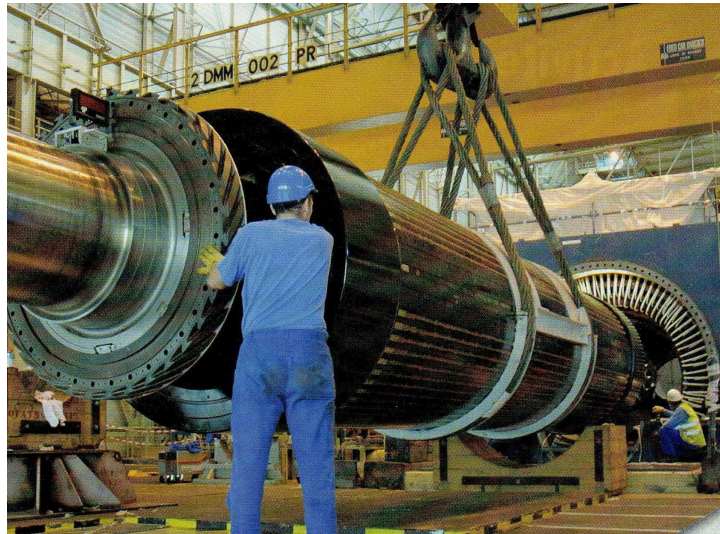
Document 2 : Intervention sur un alternateur de centrale électrique
